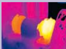
Sobrecalentamiento de rodamientos
